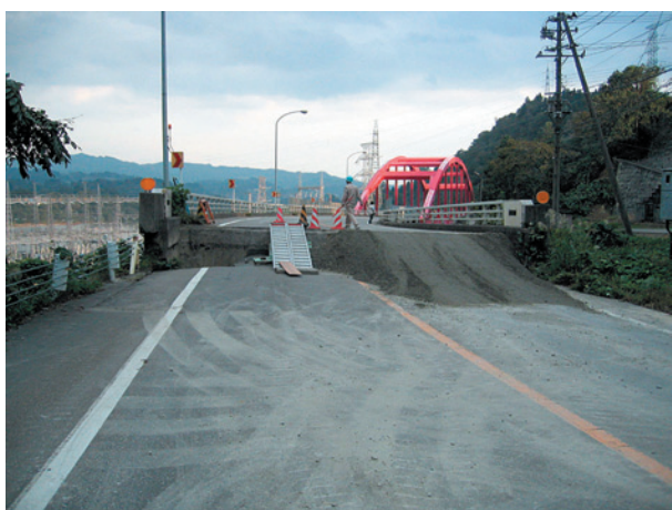
写真-9 橋梁取付け部の段差 (国道 117 号山辺橋)
