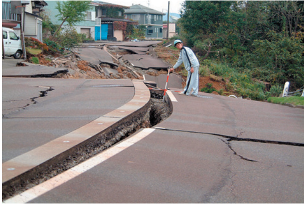
写真-12 高町団地の被害 (長岡市)
